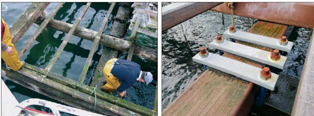
*Figure 17. « Verdín » sur poutres en bois (gauche) et poutres Formex® (droite)*
