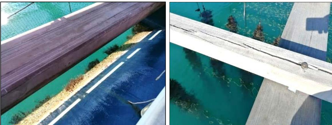
*Figure 15. Flotteur encrassé (gauche). Droite : Pieu traversé dans la longueur par une importante fissure, provoquée par une vis*
