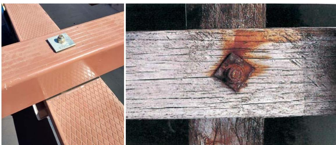
*Figura 49. Imagen de la conexión entre una viga maestra y una viga secundaria en la batea Formex®Mixta y en un emparrillado de madera*
