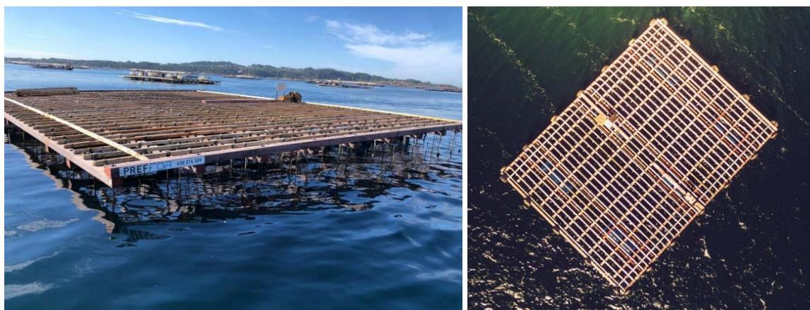
*Figura 3. Batea Formex® Mixta con dimensiones en planta 20x27 metros y 6 flotadores cilíndricos*
