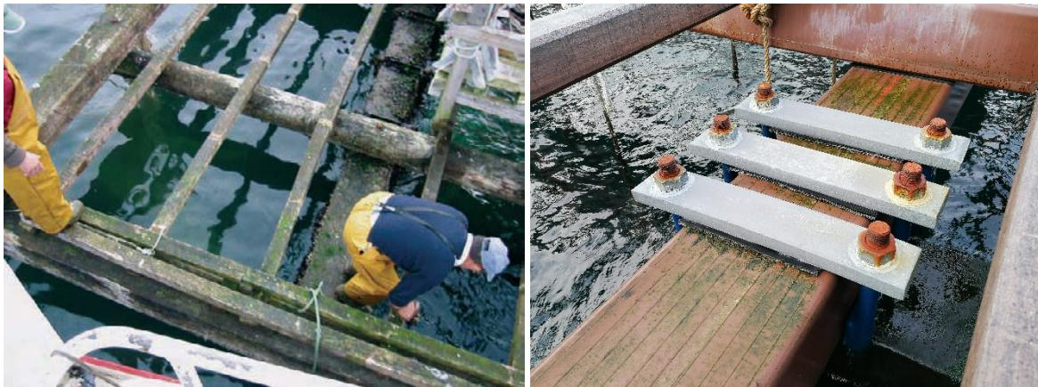
*Figura 40. Verdín en vigas de madera (izquierda) y en vigas Formex® (derecha)*
