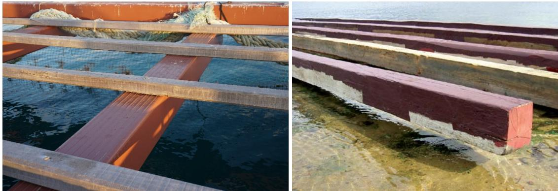
*Figura 32. Izquierda: Viga primaria de la batea Formex®. Derecha: Vigas de madera protegidas con pintura*
