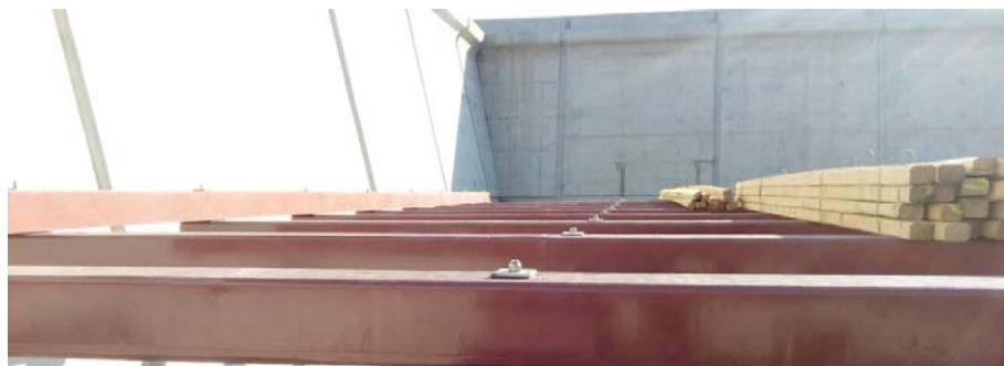
*Figura 51. Conexiones sucesivas de las vigas de través a viga maestra en batea Formex®*
