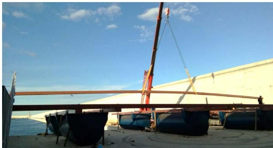
*Figura 50. Colocación de viga secundaria sobre las vigas maestras.*
