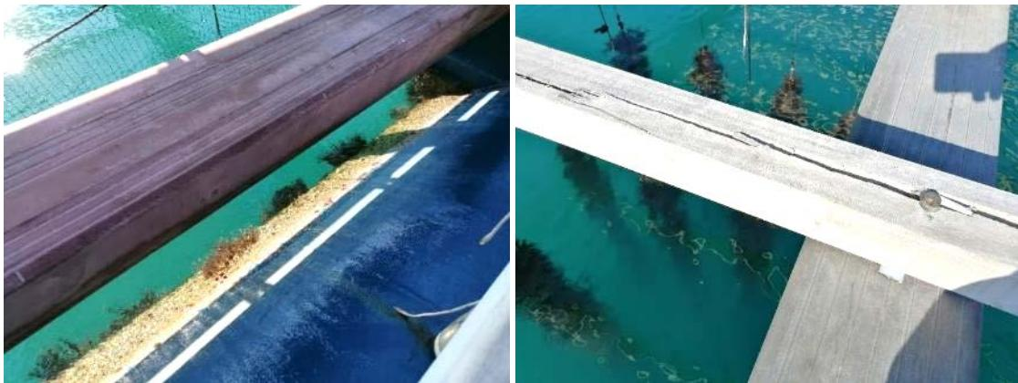
Slika broj 15: Plovak sa talogom (levo). Desno: Greda sa velikom pukotinom u sredini, izazvanom šrafljenjem.
