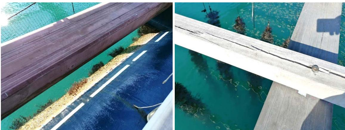
*Figura 33. Izquierda: Flotador con fouling en su superficie. Derecha: Puntón con fisura significativa generada con el apriete del tornillo*
