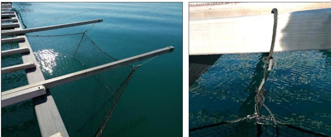
Figure 16. Gauche : Filet de protection installé. Droite : Détail du nœud pour attacher le filet à un pieu
