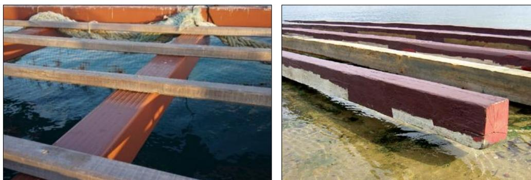
*Slika broj 14: Primarna greda na platformi Formex®. Desno: drvene grede zaštićene farbom.*
