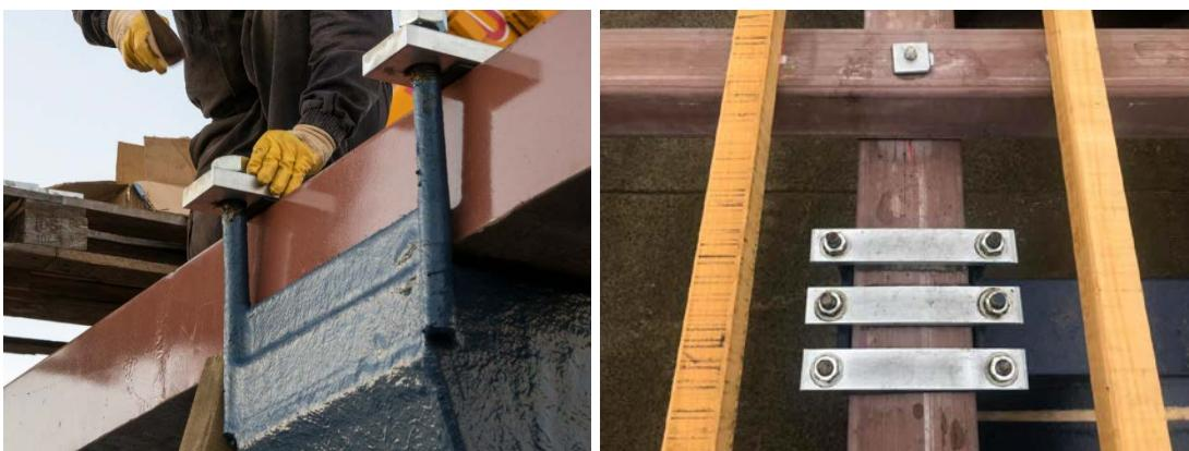
*Figura 44. Conexión entre flotador y viga maestra de una batea Formex®*
