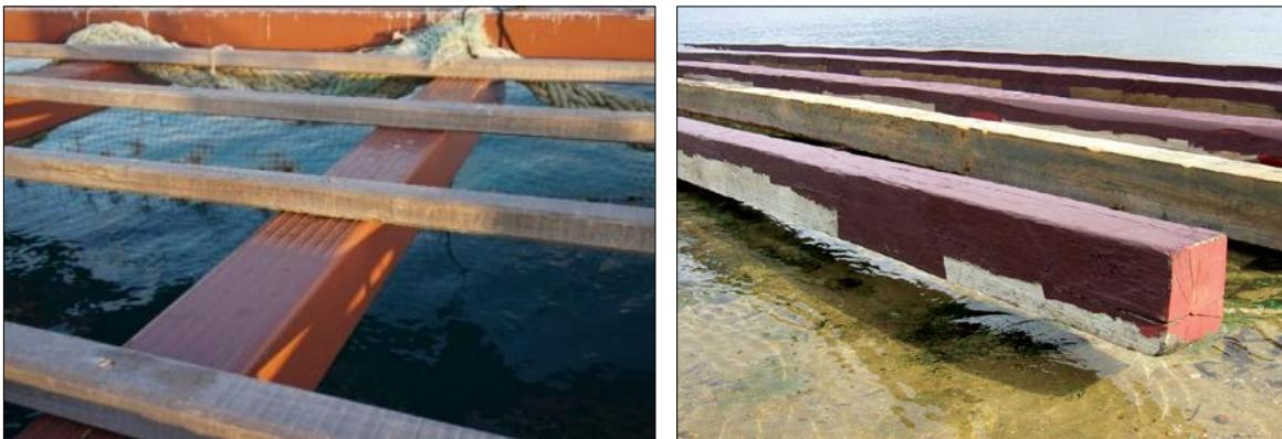
*Figure 14. Gauche : Poutre primaire d'un radeau Formex®. Droite : Poutre en bois protégée par de la peinture*
