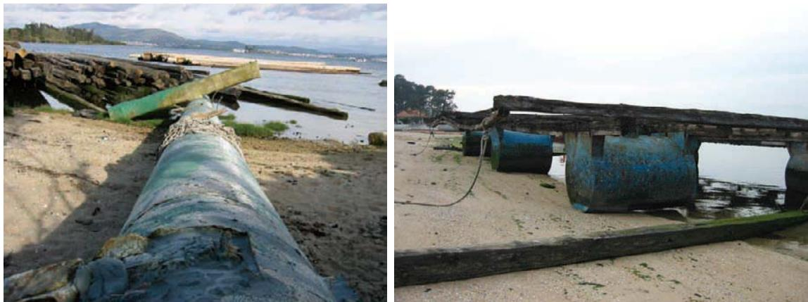
*Figura 36. Flotador de tubo y madera pendientes de retirada a gestor. Batea en desguace*
