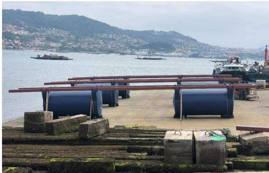
*Figura 48. Montaje de vigas maestras en una batea Formex® Mixta*
