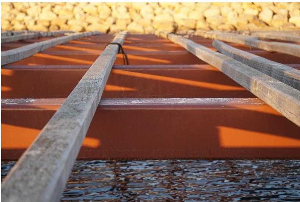
*Figura 35. Vigas de una batea Formex®. Nótese que los cantos están redondeados y la superficie es homogénea*
