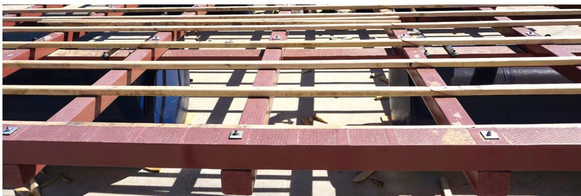
Figure 40. Conexión entre látigo y vigas secundarias. Nótesé que la rosca está hacia arriba
